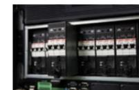
Дополнительный модуль распределения электропитания (RPDC) стоечного монтажа с модулями управления и модулями коммутационных аппаратов, поддерживающими горячую замену
